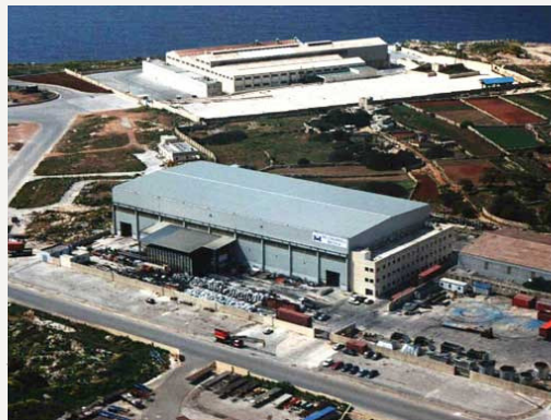
MOTHERWELL BRIDGE - COSTRUZIONI
