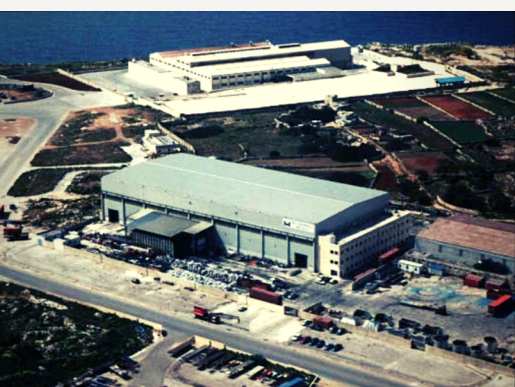
FIRETECH LTD - SICUREZZA
