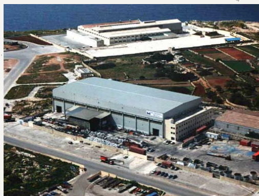
MOTHERWELL BRIDGE - COSTRUZIONI
